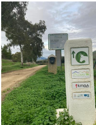
Particolare pietra miliare prefabbricata
