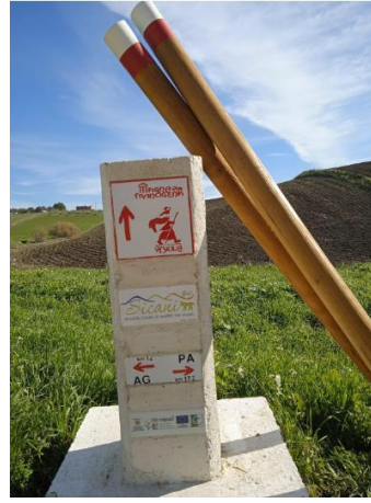
Particolare palo segnavia, pietra miliare prefab. e mattonelle in ceramica
